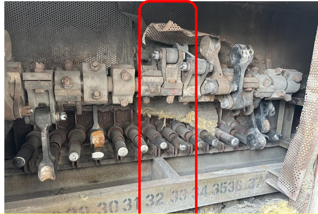
ภาพบริเวณจุดเกิดเหตุ (ค้อนเคาะ C1.1 Boiler PH-C1)
